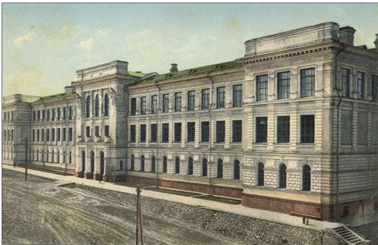
Главный корпус Томского Технологического Института Императора Николая II. Источник: [399]
